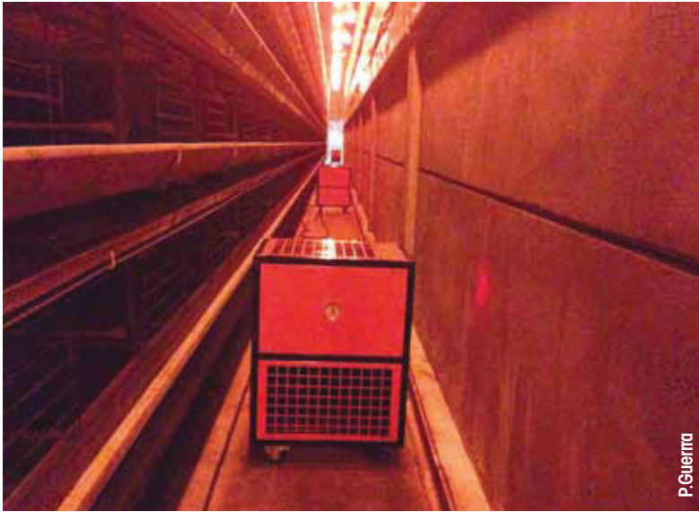
Aerotermini carrellati lungo la fila di gabbie
